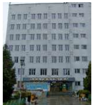
Diagnostisk bygning, laboratoriet ligger på 3. sal i 2 små lokaler.
